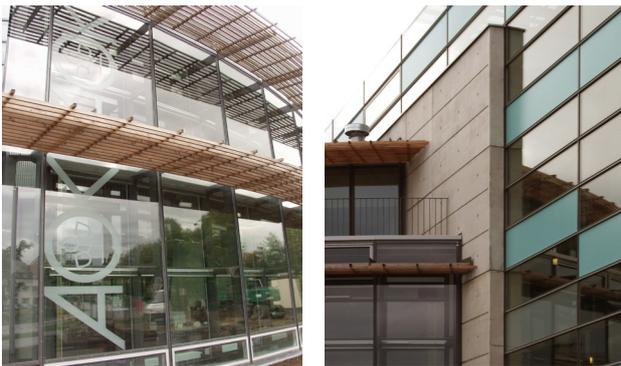
Das Tragwerk ist ein Stahlbetonskelett mit wenigen ausstehenden Wandscheiben und einem hohen Qualitätsanspruch an sichtbare Betonoberflächen, die sich teilweise mittels Kerndämmungen in die Außenhülle fortsetzen. Das Untergeschoss einschließlich einer Tiefgarage bilden eine fugenlose, wasserundurchlässige Konstruktion im Grundwasser. Nicht überbaute Teile der Tiefgarage werden mit Zugpfählen dauerhaft gegen Aufschwimmen gesichert.
